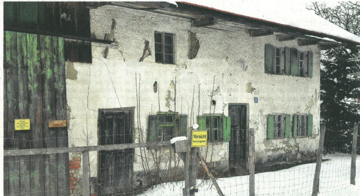
Der Förderverein hat ein Konzept für die Sanierung des Rochlhauses erarbeitet.
