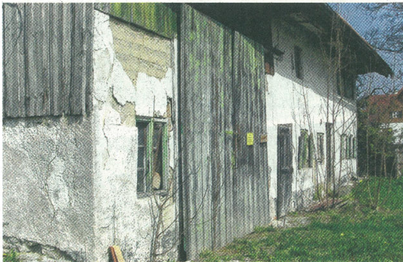
Die Untersuchungen am Thaininger Rochelhaus können starten. Foto: Ulrike Reschke
