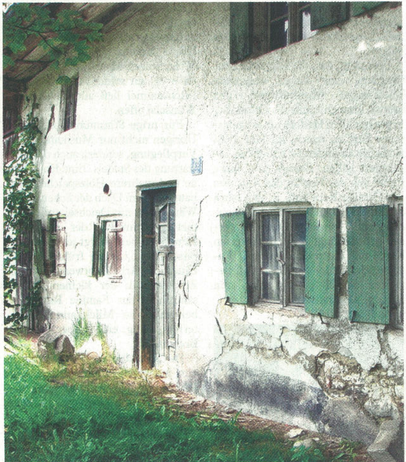
Zerbrochene Fenster und schief in den Angeln hängende Läden sind noch die kleinsten sichtbaren Schäden an dem 358 Jahre alten Rochelhaus. Foto: Ulrike Reschke
