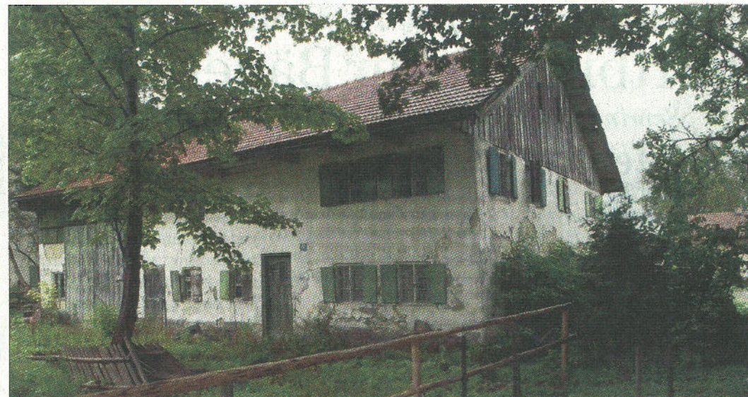
Das Rochel-Haus in Thaining ist wohl das älteste erhaltene profane Gebäude des Dorfes. Deshalb soll es erhalten bleiben und wurde von der Gemeinde gekauft. Foto: Sibylle Seidl-Cesare
