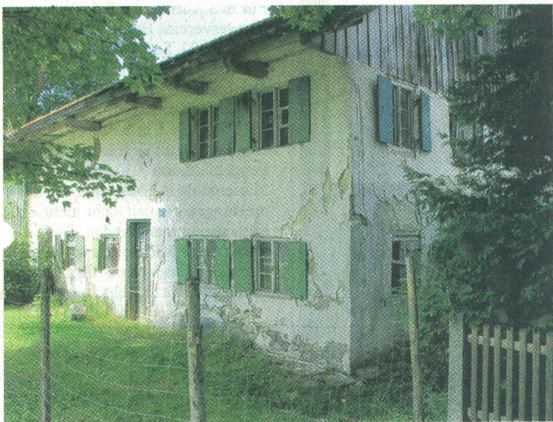
Wird das Rochelhaus saniert, soll der Dachstuhl um einen Meter tiefer gesetzt werden, um den 1860 veränderten Originalzustand wieder herzustellen. Fotos: Reschke
